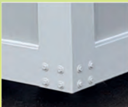
Particolare della bulloneria ad innesto
