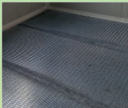
Pavimento rinforzato in lamiera mandorlata con spessore 30 dec., zincato a caldo
